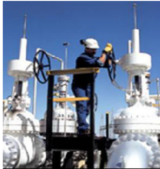
Fig 1. Estación de bombeo ecopetrol
